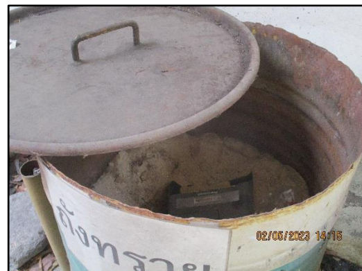
ภาพที่ 2.20 ถังทรายดูดซับน้ำมันบริเวณท่าเทียบเรือของโครงการ
