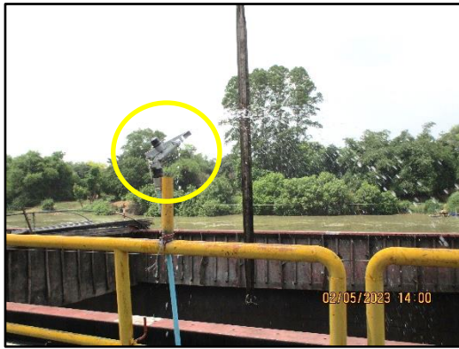
ภาพที่ 2.4 การติดตั้งสเปรย์น้ำบริเวณที่มีการลำเลียงถ่านหินขึ้นจากเรือ
