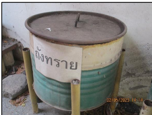
ภาพที่ 2.20 ถังทรายดูดซับน้ำมันบริเวณท่าเทียบเรือของโครงการ
